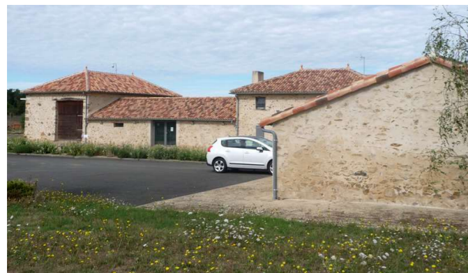
Locaux du site de stockage
