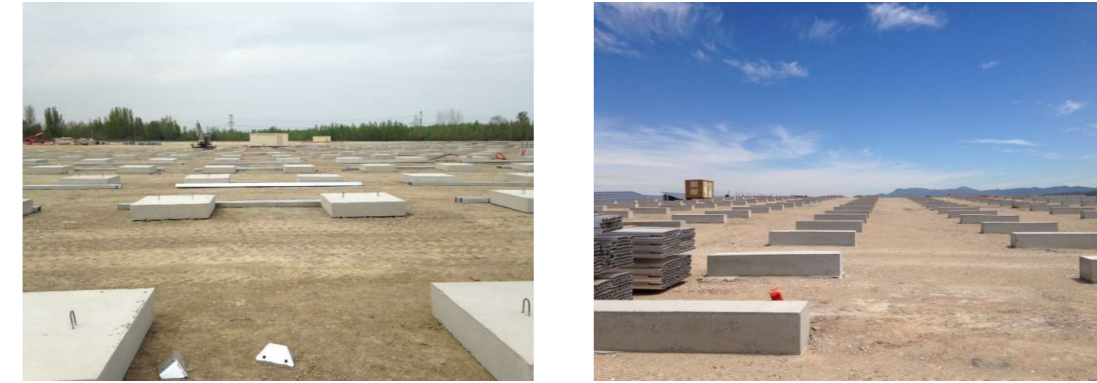
Longrines béton (crédit photo : Urbasolar)
