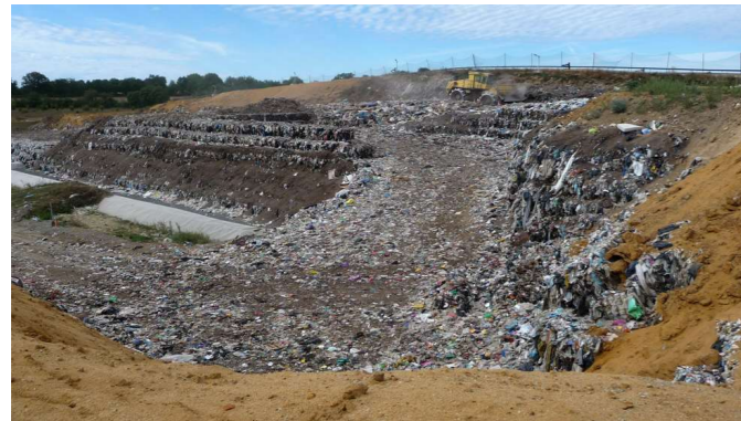
Secteur en cours de comblement
