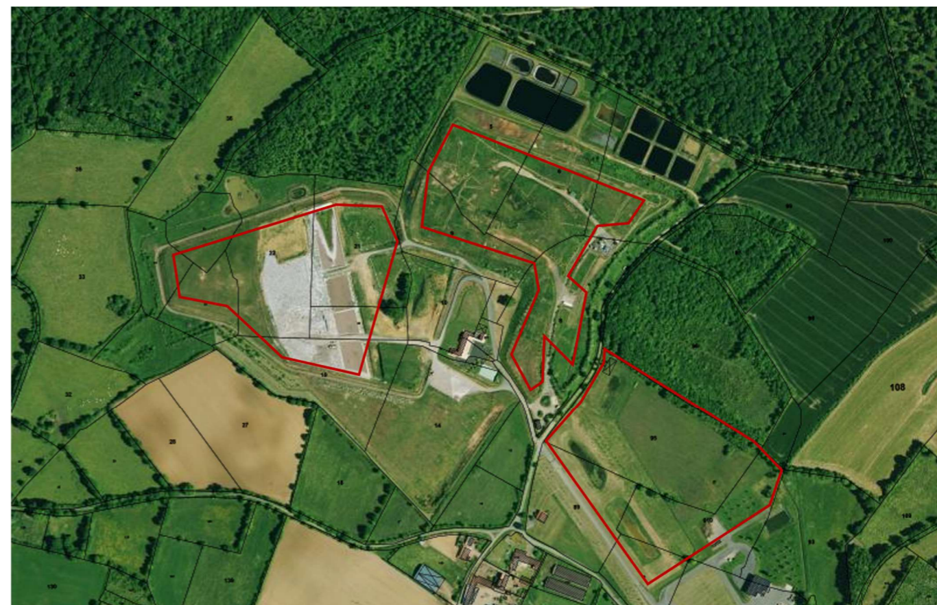
Zones du site de Coulonges-Thouarsais potentiellement disponibles pour l'implantation d'unités photovoltaïques
