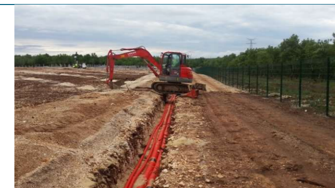
Création de tranchée pour enfouissement des lignes HTA (crédit photo : Urbasolar)
